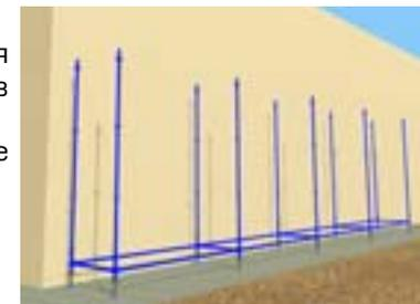
5. Связать вертикальные стойки горизонтальными элементами. Разместить в рабочей зоне настилы и лестницы.
